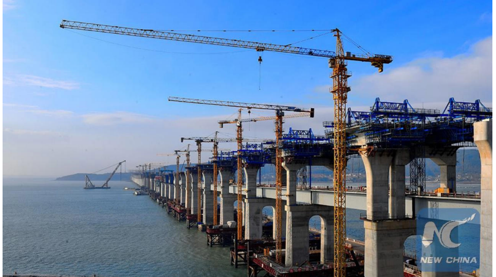
El puente ferroviario y autopista a través del estrecho de Pingtan, que se construye en la provincia suroriental de China, Fujian. 2017. (Xinhua/New China)
